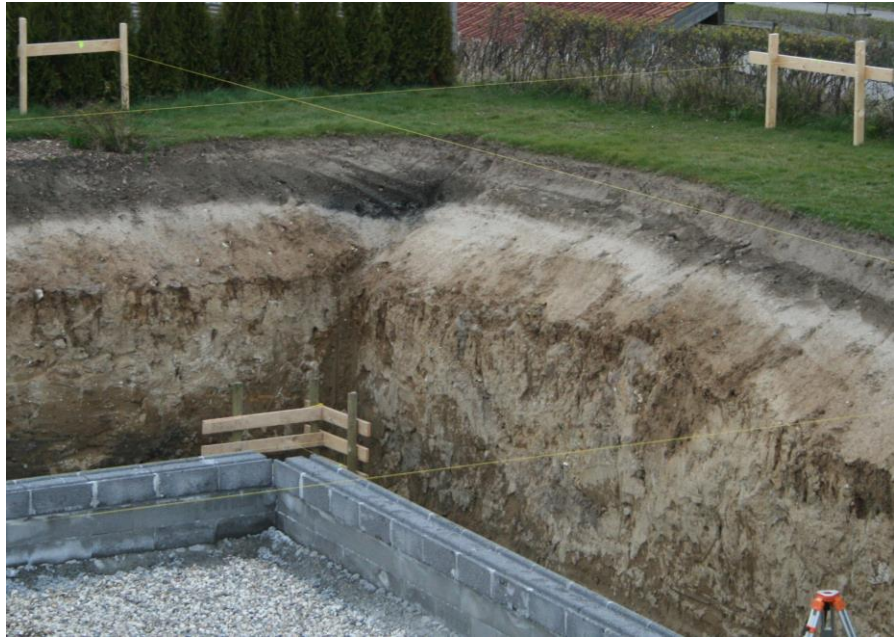
Udgravning til nybyggeri 2008
