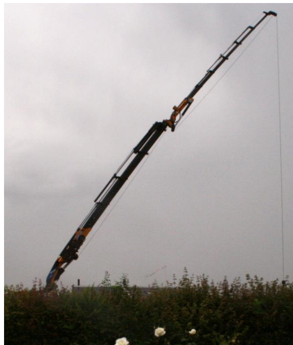
Byggekrant på Bautavej 2008
