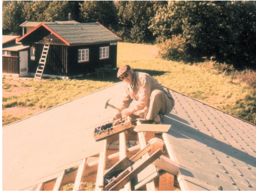
Taglægning på Bautavej 5 - bagved ses Bautavej 3, som bar navnet Havannah
